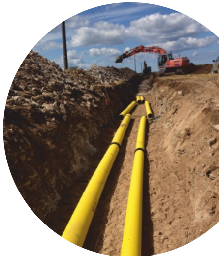
Estlink 2 Topeltseinaga kaablikaitsetoru paigaldus diameetriga 250 ja 315 mm
